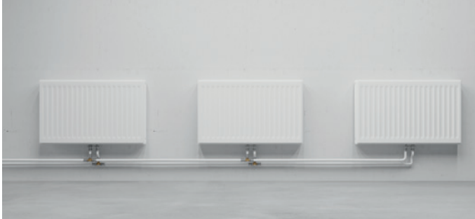
Fig. 47: Het klassieke verwarmingssysteem met 2 buizen.
