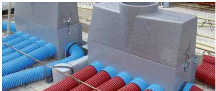
Montagevoorbeeld luchtverdeelkast voor gebalanceerde ventilatie
