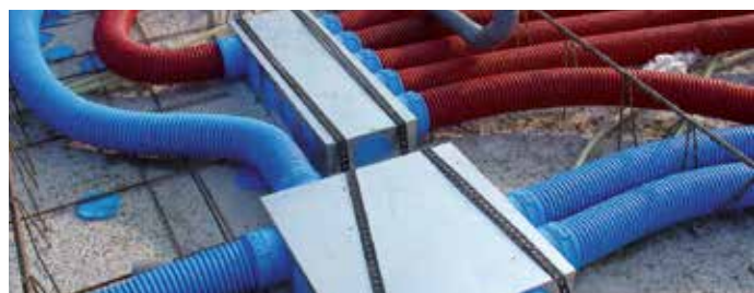
Montagevoorbeeld luchtverdeelkast haaks/recht met aanzuigplenum 400 x 400
