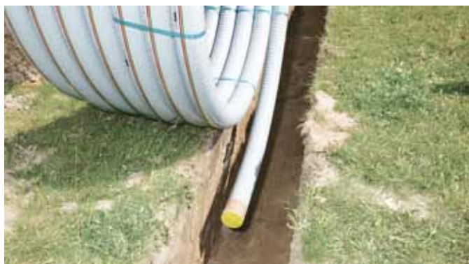
Afb. 52. Rol per laag losmaken
