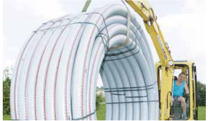
Afb. 47. Optillen met de graafmachine
