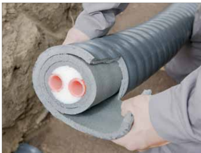
Afb. 9. Isolatie verwijderen van de buis
