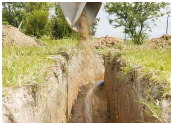
Afb. 56. Buissleuven met zand vullen
