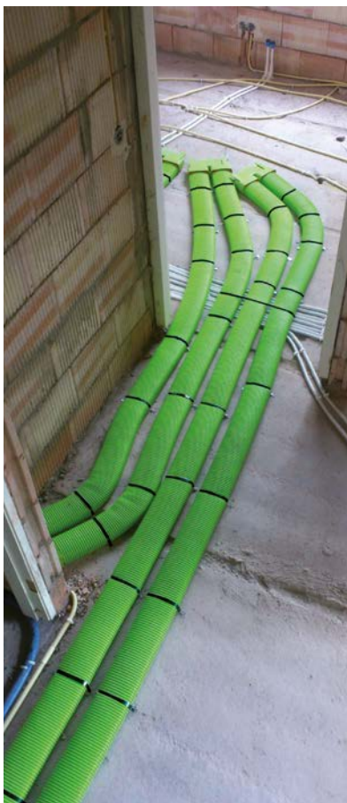
Nieuwbouw woning Heino
