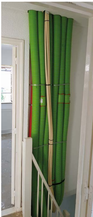
Renovatie woning Gemert
