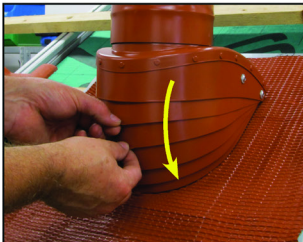
Lamellen gleichmäßig verteilen
