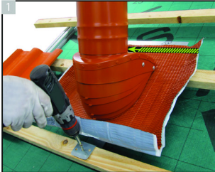
Abb.1: Kompriband mit ca.10mm Abstand zur oberen Kante anbringen (3 Stück) Torx 5x30-50 (3 Stück)
