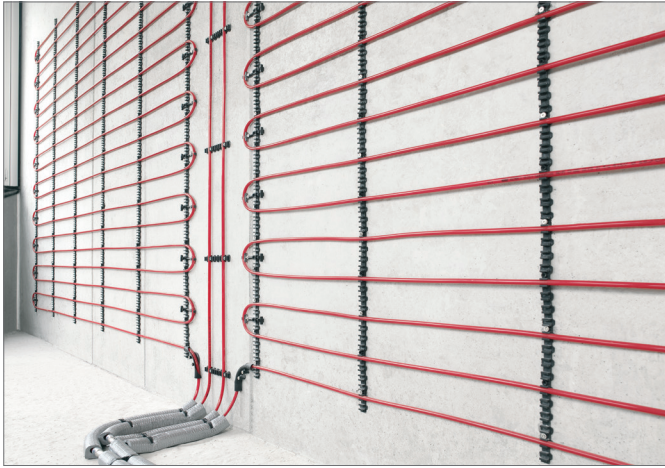
Afb. 4-16 REHAU wandverwarming/-koeling in natte opbouw
