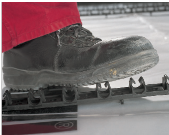
Afb. 3-34 RAUFIX-rail in vloeropbouw drukken
