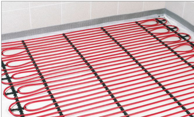
Afb. 3-73 Vloerklemrail in natte constructie
